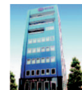
⑨東京支店 (西麻布ビル)
