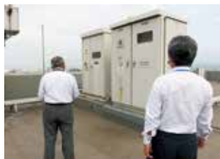
現場審査 (本社ビル)
