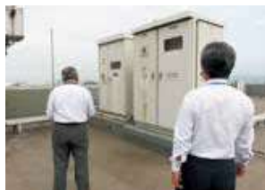
現場審査(本社ビル)
