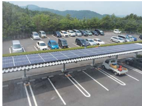
テクノセンター来客用駐車場屋根
