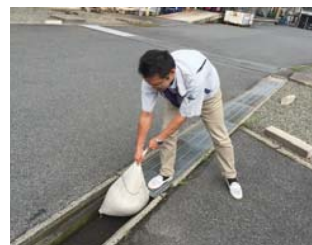
土嚢を使用して流出防止
