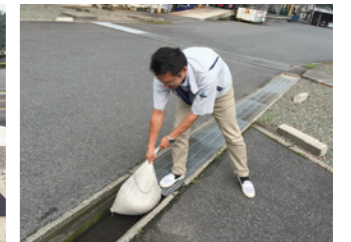
土嚢を使用して流出防止
