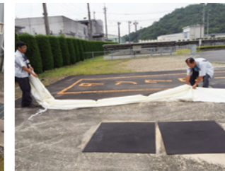
オイルフェンスを使用して流出防止
